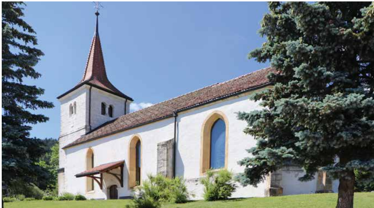
Le temple de Cernier: seul bâtiment qui fait l'objet d'une protection totale. (Photo pif).
