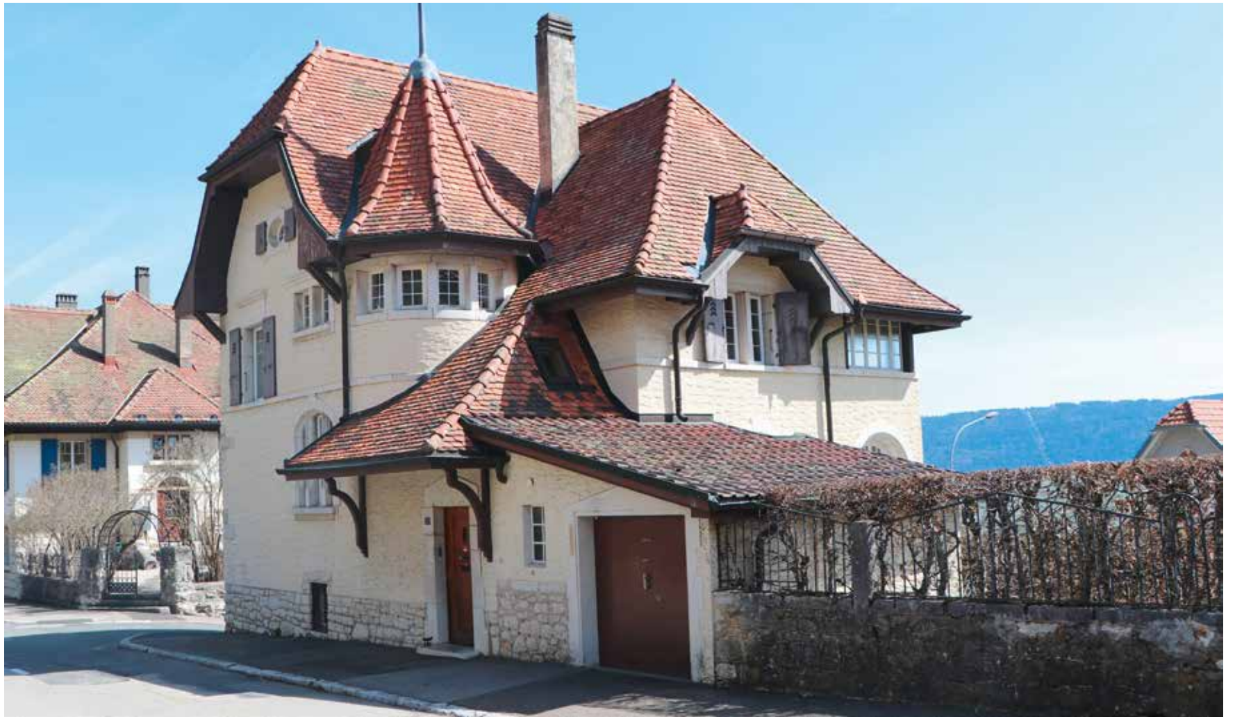
Coup d'œil sur le patrimoine bâti de Cernier. (Photo pif).
